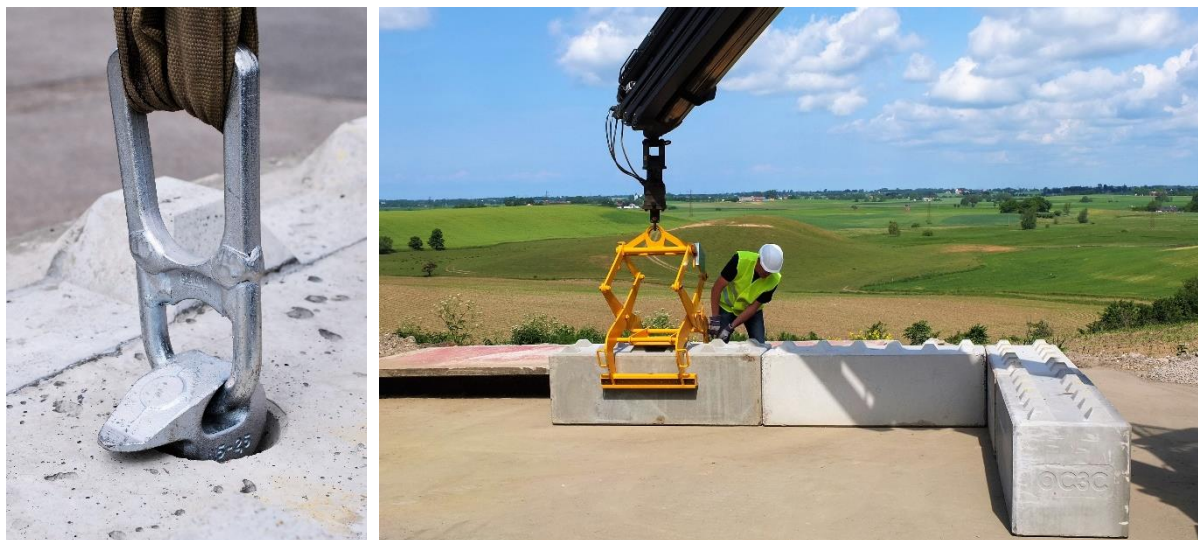
Figur 6.4a-b. Blokkhåndtering ved hjelp av universalhode og mekanisk klemmeinnretning.
