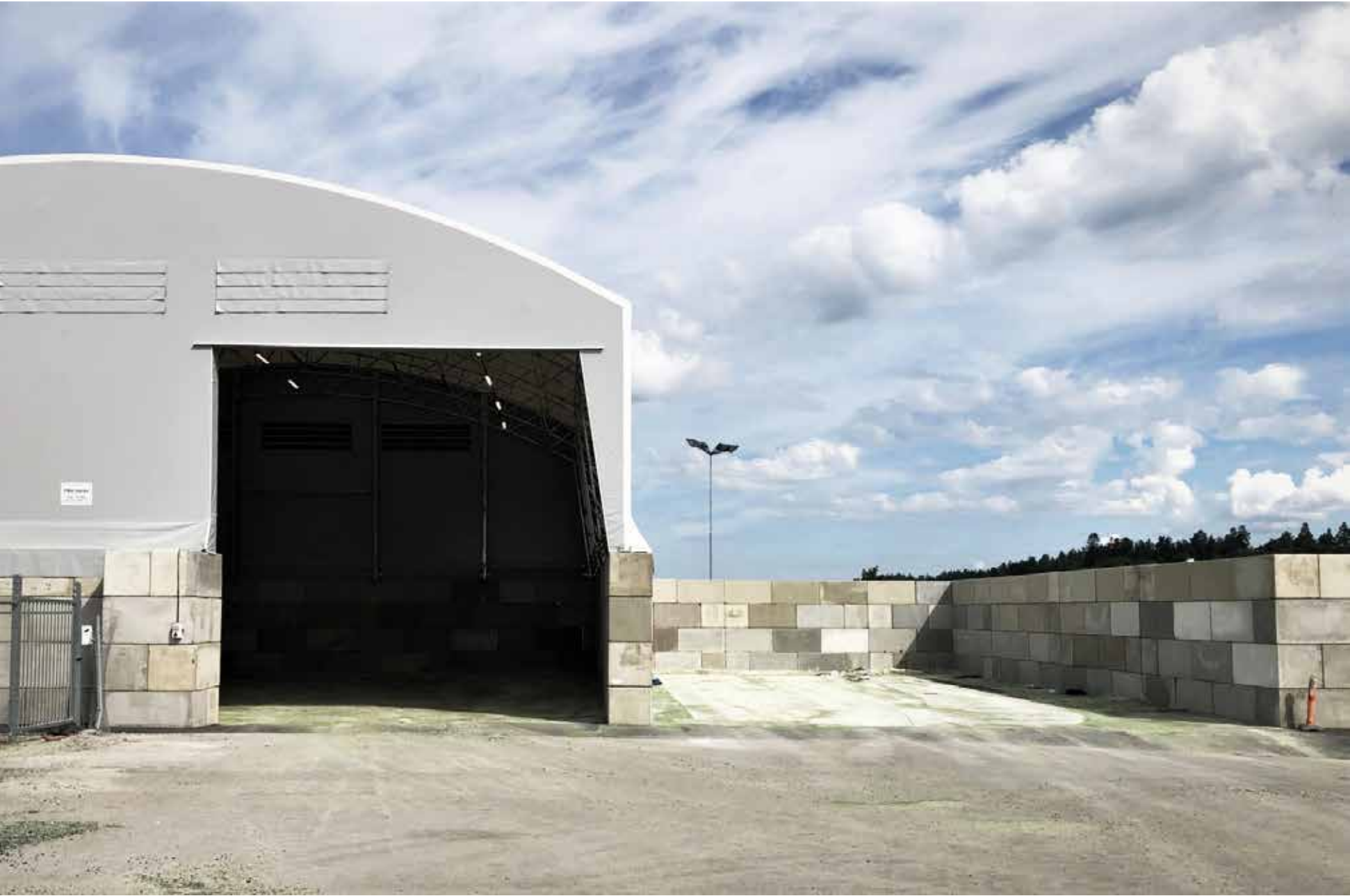
SORTERINGSSTALL IHOPBYGGD MED UTVÄNDIGA MATERIALFICKOR. SVENSK GLASÅTERVINNING I ASKERSUND.
