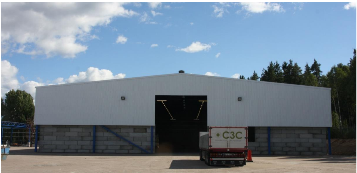
Figur 1d. Lagerhall utförd med C3C Blocksystem®
