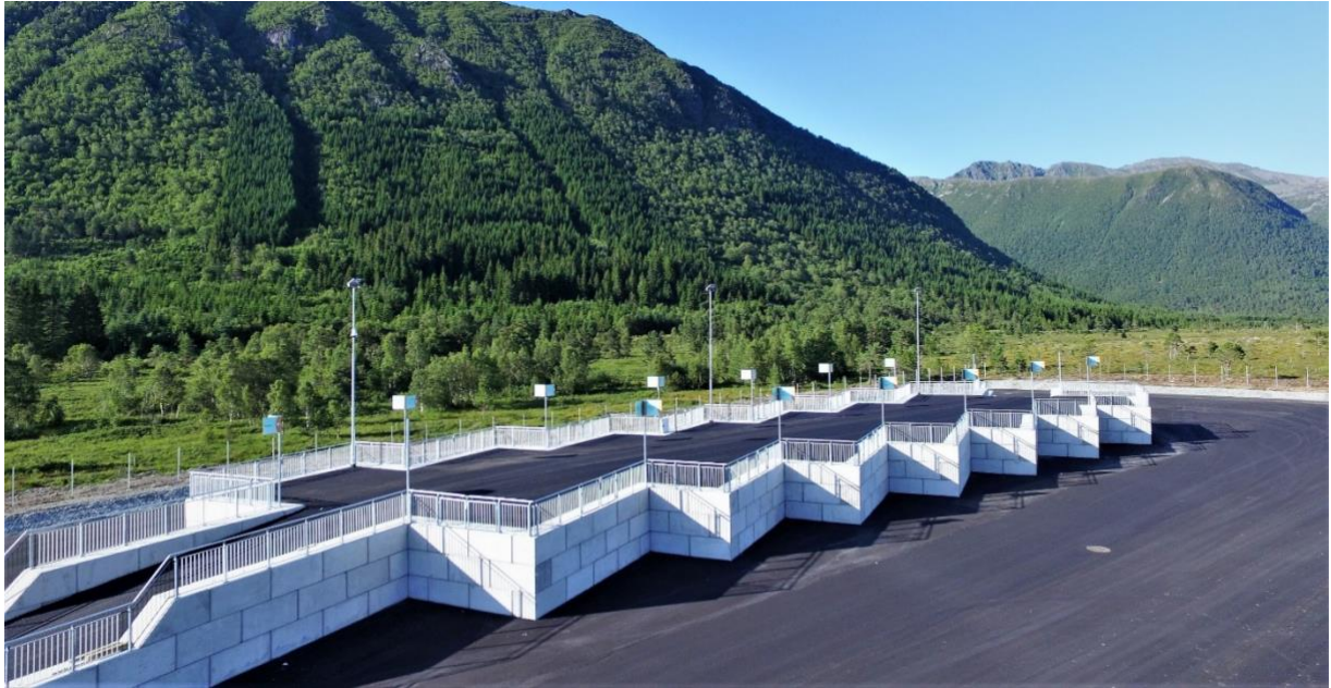
Figur 1a. Avfallsstation, Containerramp utförd med C3C Blocksystem®
