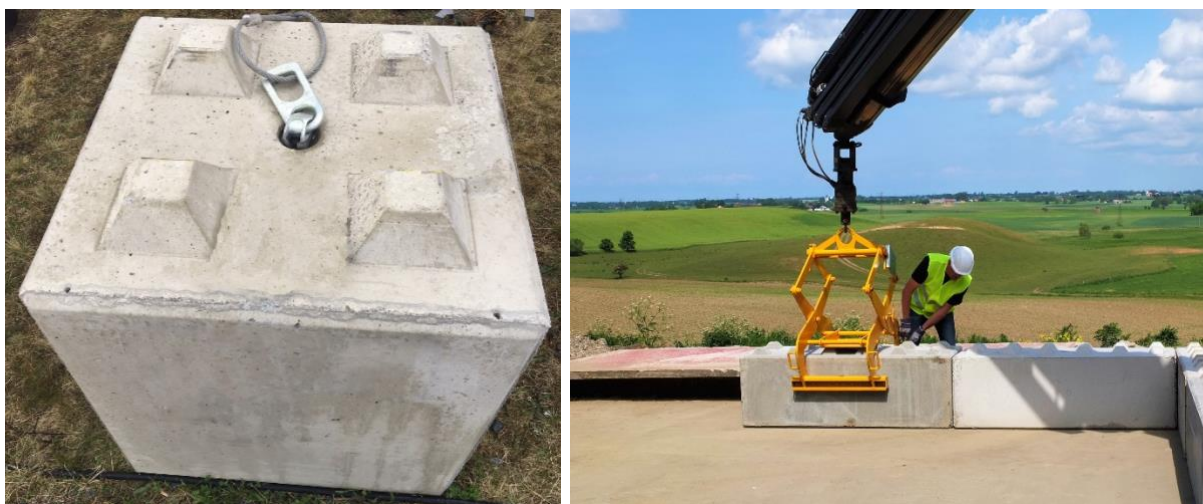
Figur 6.4a-b. Blockhantering med hjälp av universalhuvud samt mekaniskt klämliftdon.
